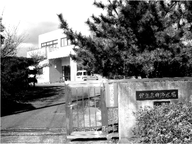
裾野市伊豆島田にある三島市浄水場
