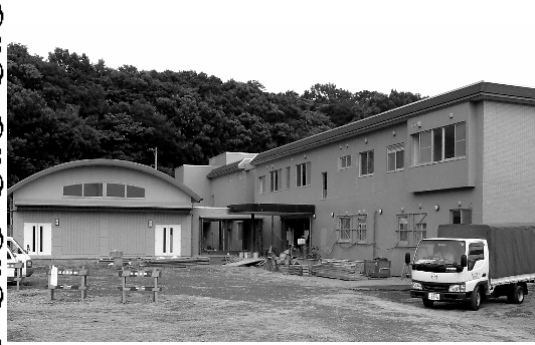
建設中の北上文化プラザ 6/27
