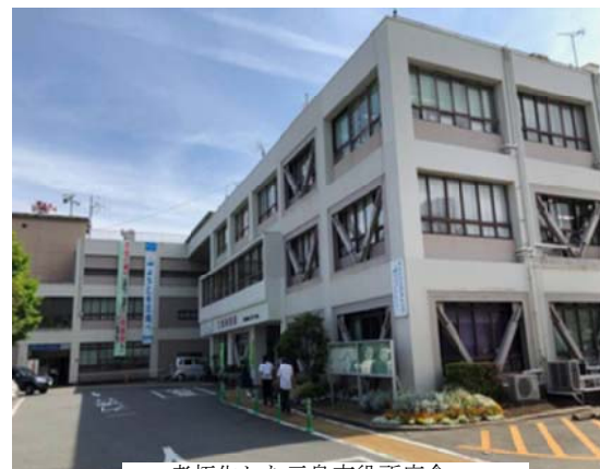
老朽化した三島市役所庁舎
