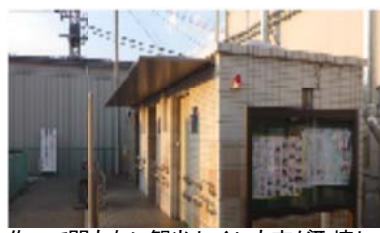
作って間もない観光トイレも市が取壊し跡地が売却される
