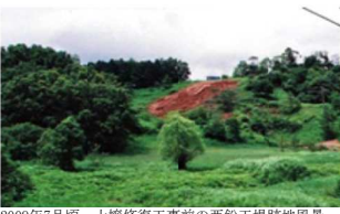
2009年7月頃 土壌修復工事前の亜鉛工場跡地風景
